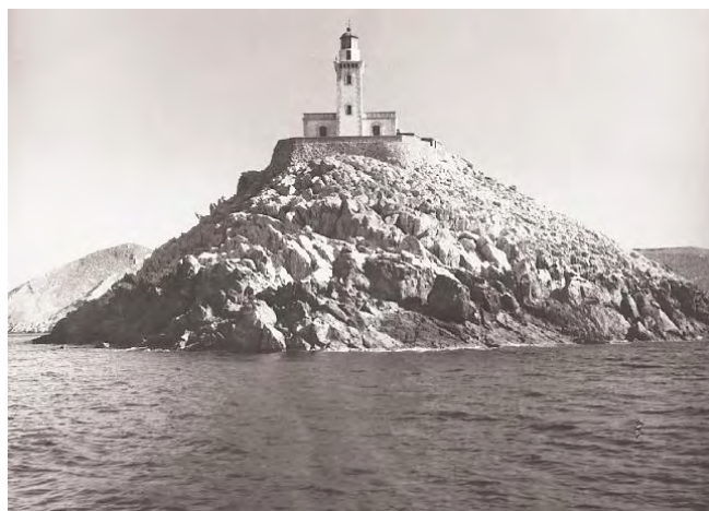
Εικόνα 107. Ο Φάρος του Ακροταίναρου κατασκευάστηκε το 1882 (φωτ.: Ν. Μπένου – Πάλμερ)
