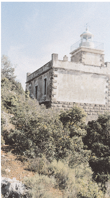
Εικόνα 50. Ο Φάρος των Κιτριών, κατασκευασμένος το 1842 ξεχωρίζει για τους σκουρόχρωμους γωνιολίθους του και τα μαρμάρινα πλαίσια των ανοιγμάτων του (Φωτ. : Γ. Σαΐτας)
