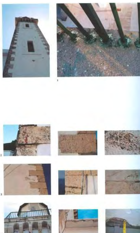
Εικόνα 81. Παθολογία, μορφές διάβρωσης φάρου Γουρούνι
