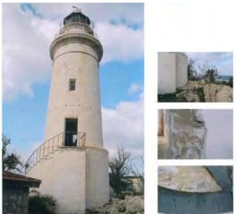
Εικόνα 43. Φάρος Πάφου, Κύπρος. Θεμελίωση-λιθοδομή.
