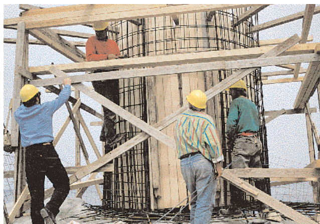
Εικόνα 47. Η πρώτη φάση της ανακατασκευής του Τουρλίτη.
