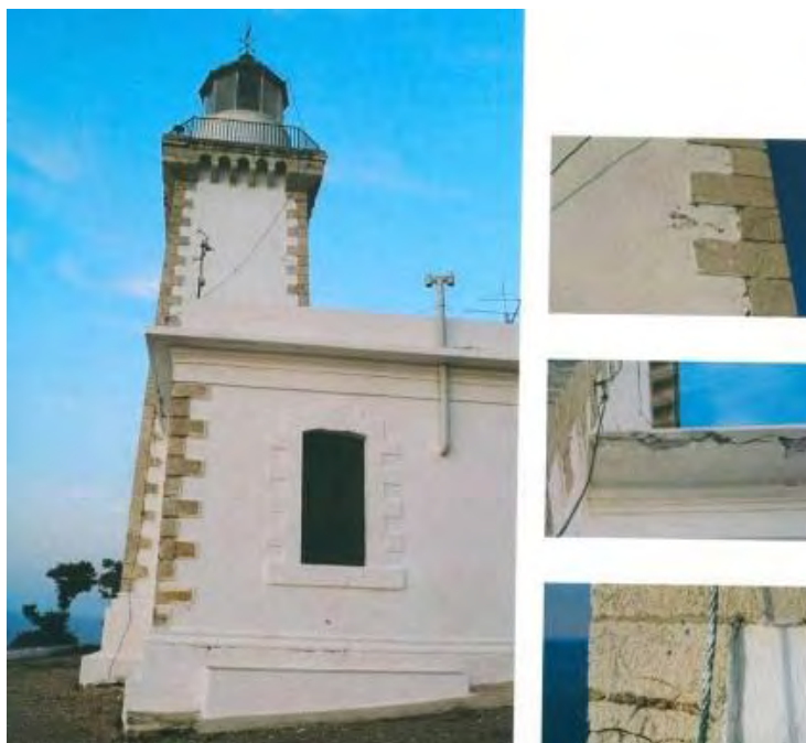
Εικόνα 42. Φάρος Γουρούνι, Σκόπελος.Λιθοδομή
