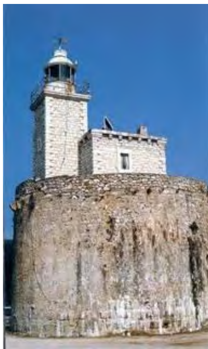
Εικόνα 19. Φάρος στο φρούριο Λευκάδας. Τετραγωνική κάτοψη με ισόδομο σύστημα κατασκευής
