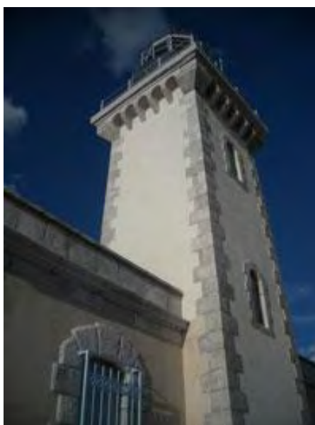
Εικόνα 111. Ο φάρος του Ταινάρου μετά την αποκατάσταση ( http://www.laskaridou.gr/page.php?cat=50&view=1800 )
