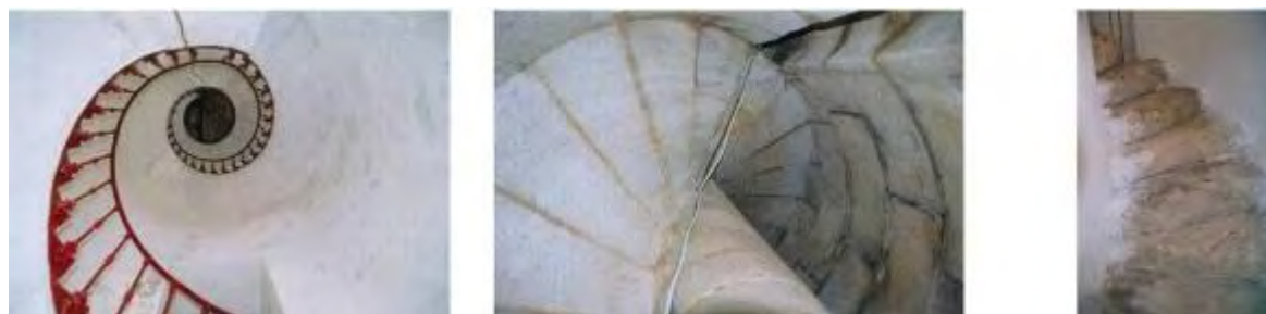
Εικόνα 48. Κλιμακοστάσια φάρων Ψαθούρας, Γουρούνι, Πάφου, Ταίναρου
