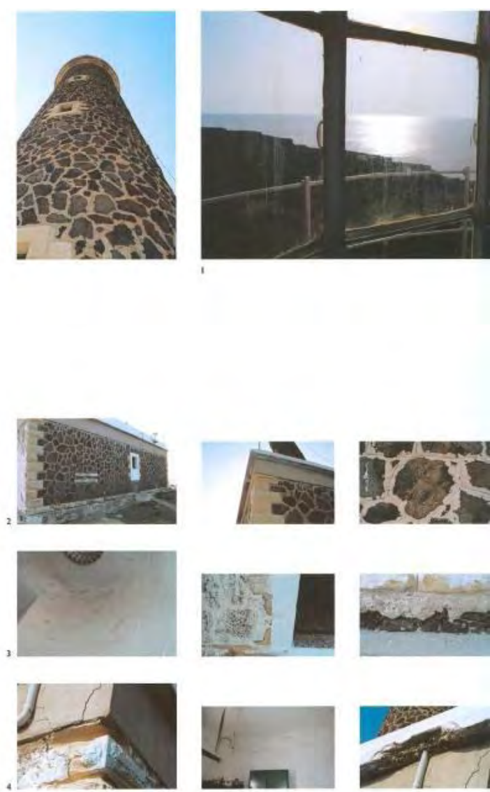
Εικόνα 80. Παθολογία, μορφές διάβρωσης φάρου Ψαθούρα
