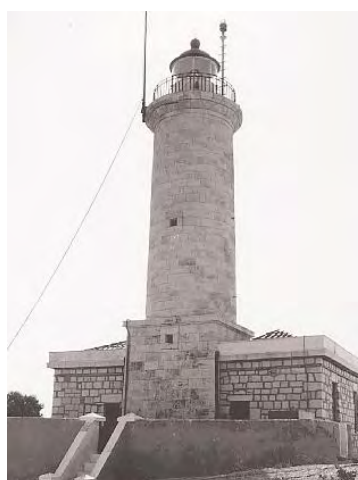
Εικόνα 44. Ο φάρος της Ψυττάλειας, στη Β.Α. ακτή του νησιού, ήταν ο πρώτος διοπτρικός φάρος, που λειτούργησε στα ελληνικά παράλια από το 1856. Κτίστηκε με πέτρα λαξευμένη, τετράγωνος στη βάση και στο ύψος του φαρόσπιτου, κυλινδρικός από τη σκεπή του και πάνω.
