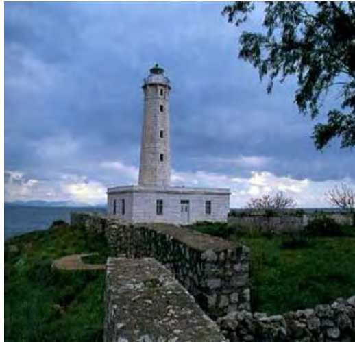
Εικόνα 21. Φάρος Κραναί, Γύθειο.Οκταγωνική κάτοψη με ισόδομη κατασκευή ( http://www.faroi.com/gr/kranai_gr.htm 0
